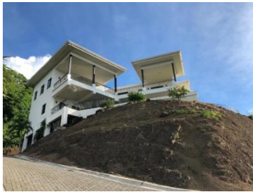
Imagen 7. Sitio fuente de las transmisiones de la frecuencia 104,1 MHz dentro del Condominio Coco Bay Estates.
